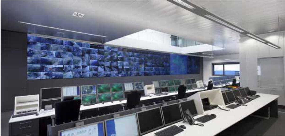
Die Verkehrsleitzentrale München ist Europas modernste zentrale Steuerungseinheit zur Lenkung und Überwachung des Verkehrs und der Betriebstechnik. Eine 17 Meter breite Multimediawand visualisiert die Verkehrslage und die Betriebszustände der technischen Anlagen aller Münchener Hauptstraßen. Die Bilder von rund 400 Kameras werden hier ausgewertet.
